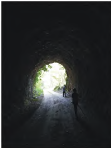
Tunel u Dobrunu.
